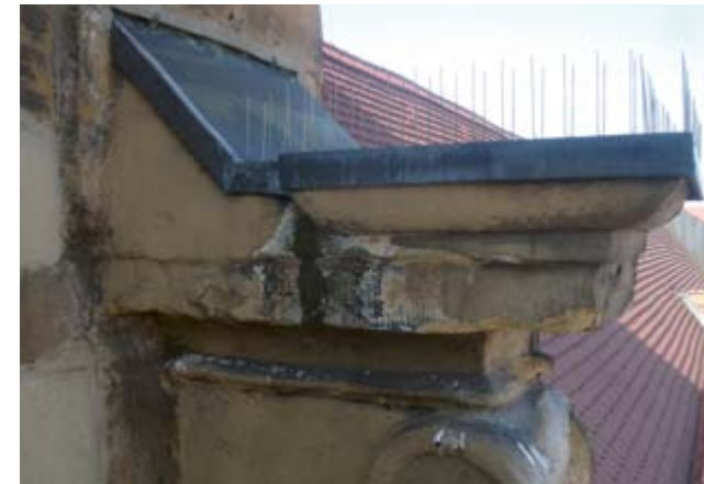
Man erkennt hier z.B. offene Fugen, Abplatzer und falsches Reparaturmaterial
