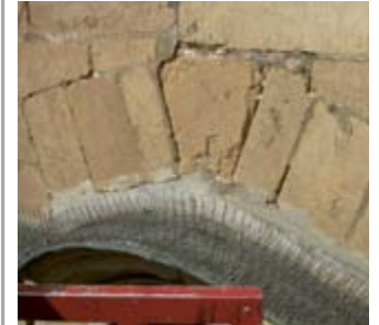
Man erkennt hier z.B. offene Fugen, Abplatzer und falsches Reparaturmaterial
