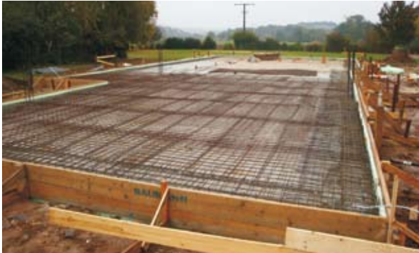
Die Bodenplatte kurz vor der Vollendung
