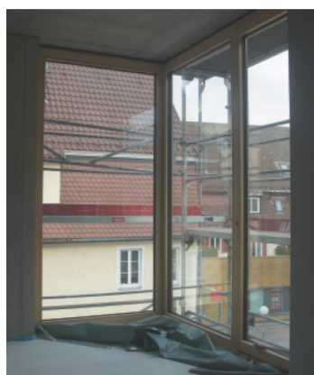
An der SO-Ecke findet man raumhohe Fenster mit Blick auf den Gmünder Torplatz und den Rand der Innenstadt.
